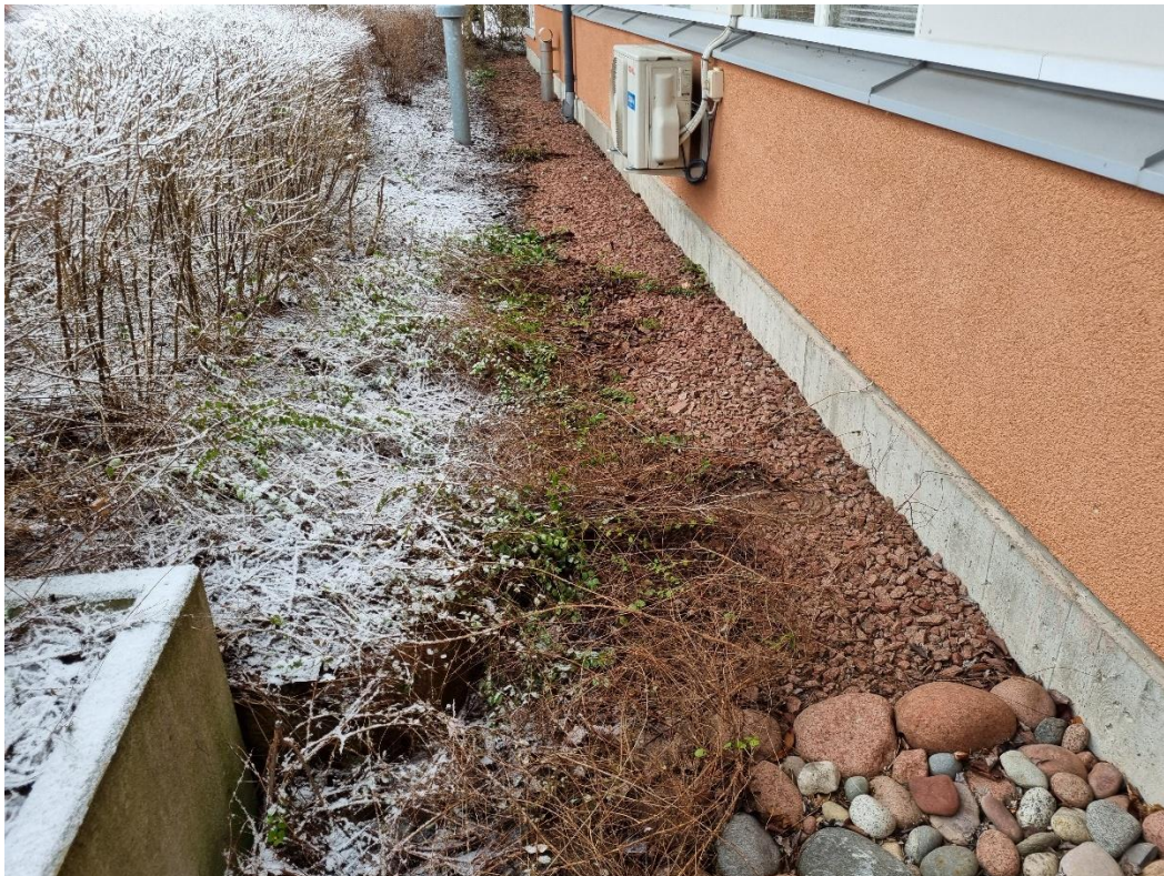
Figur 4 Fasad intill teknikgrund, möjlig placering av fördelningsbrunnar samt kulvertanslutning till teknikgrund.
